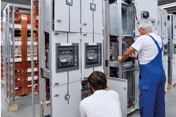
配電箱盤的組裝
